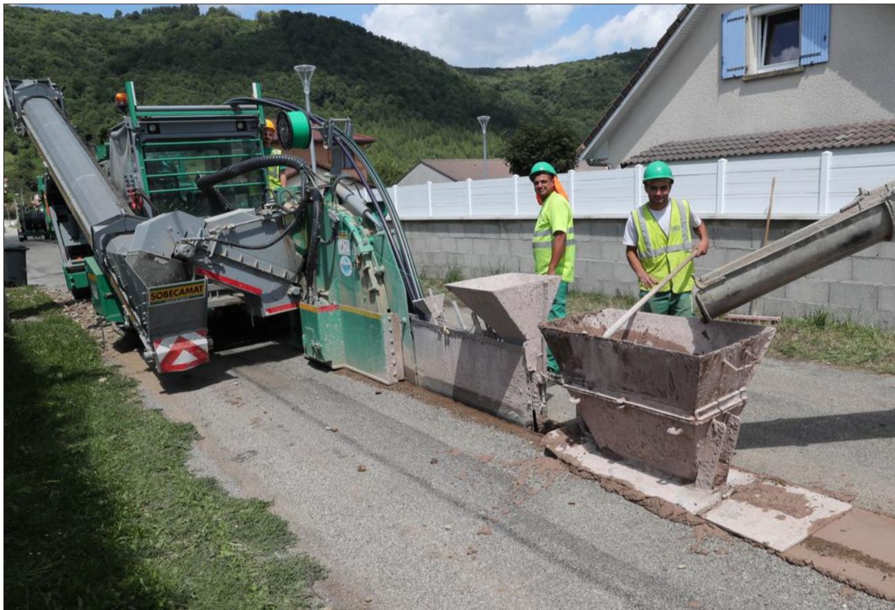
Les premiers travaux ont débuté la semaine dernière dans la commune d'Apprieu. Photo Le DL/Michel THOMAS
