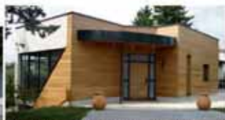
Extension de maison individuelle
