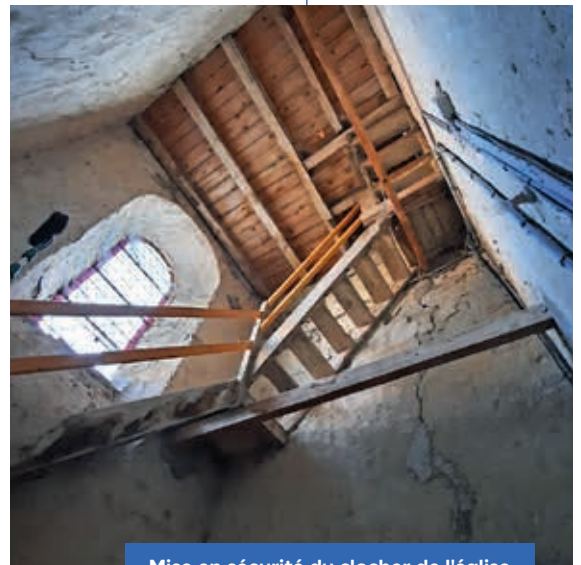
Mise en sécurité du clocher de l'église
