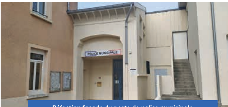
Réfection façade du poste de police municipale
