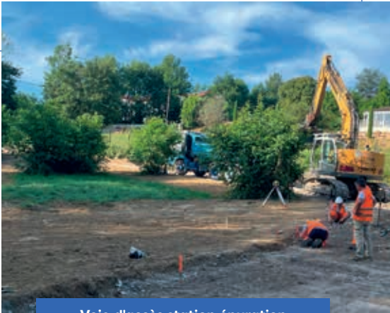
Voie d'accès station épuration
