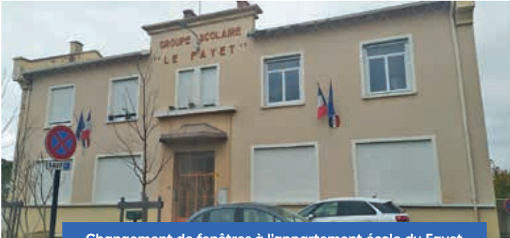
Changement de fenêtres à l'appartement école du Fayet
