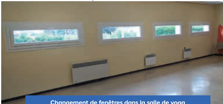
Changement de fenêtres dans la salle de yoga
