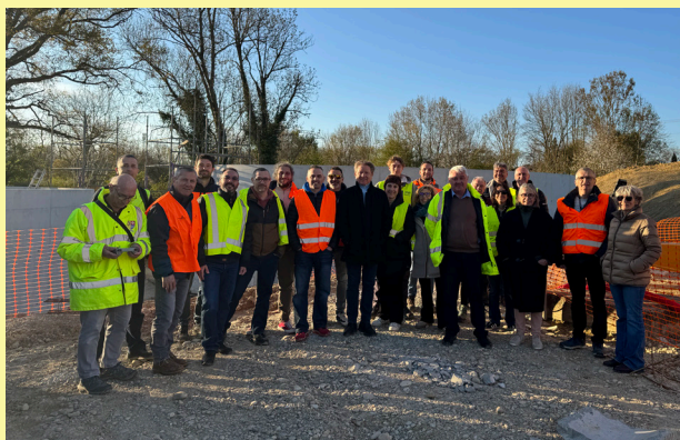
Suivi de l'avancement des travaux de la station d'épuration en présence des acteurs du chantier.
